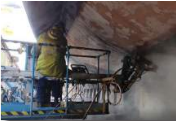
Liftworker FALCH trabajando en pantoque
