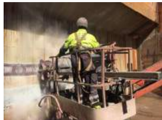
Liftworker FALCH siendo utilizado en casco y bodegas
