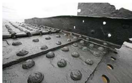
Detalle de remachado
