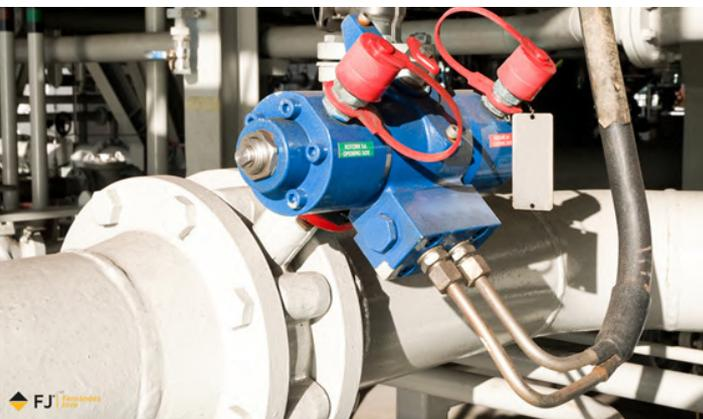
**Ilustración 4- Actuador hidráulico sobre válvula de mariposa**
