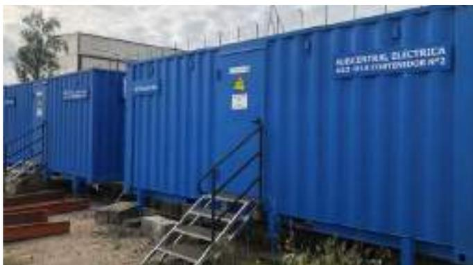
Figura 3. Subcentrales portátiles provisionales utilizados para el bypass del edificio municipal.
