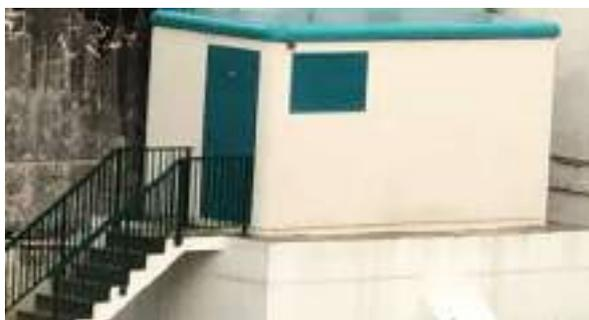
Figura 4. Nuevo centro de seccionamiento con nueva alimentación en 15kV.
