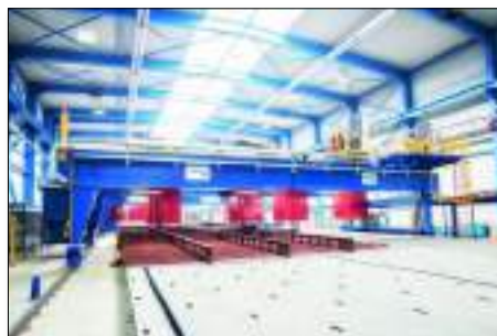
Figura 7. Actual línea de paneles que incluye soldadura láser-híbrido de paños y refuerzos de MV WERTFEN, desarrollada e instalada por PEMAMEK.
