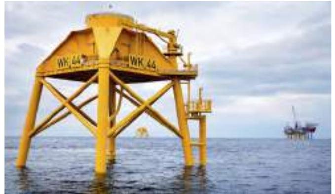
A la hora de definir el proceso de selección de un sistema de protección pasiva contra la corrosión se han de tener en cuenta una serie de factores. Se requiere primeramente conocer la agresividad corrosiva del medio así como las características de la estructura y de la superficie a la cual se aplicará el recubrimiento. Finalmente para poder elegir el sistema adecuado se debe de conocer la durabilidad requerida del mismo y una planificación del proceso de pintado.
